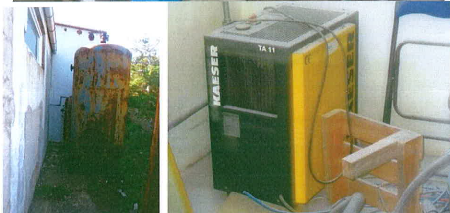
Slike 31 do 33. Kompresor sa spremnicima i sušačem zraka
